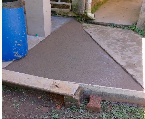
Construcción de piso en concreto. (Zona de juegos de la sede secundaria).
