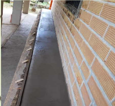
Instalación de canoa. (Zona de juegos de la sede secundaria).
