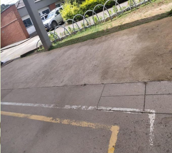
Adecuación zona aledaña a la placa
