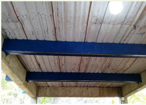
Cambio de cubierta en PVC. (Bloque 2 de la sede secundaria).
