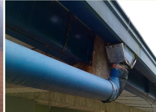
Cambio y mantenimiento de bajante. (Bloque 2 de la sede secundaria).
