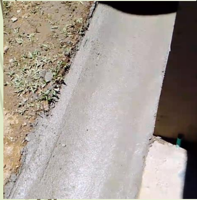
Construcción de Cuneta. (Zona de juegos de la sede secundaria).
