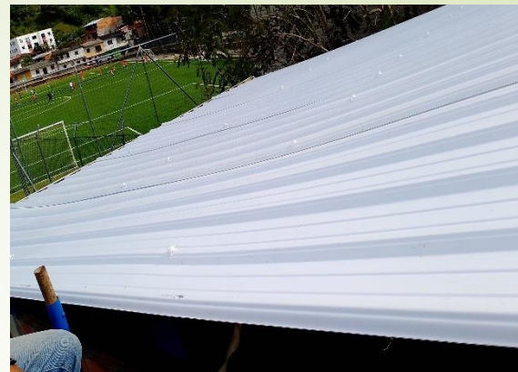
Cambio de cubierta en PVC. (Bloque 2 de la sede secundaria).
