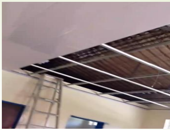
Instalación de cielo raso. (Cafetería de la sede primaria).
