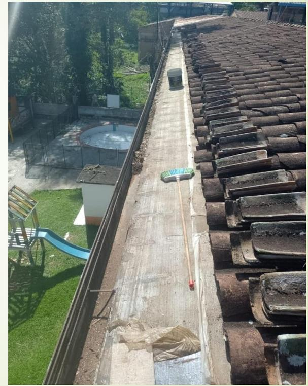
Suministro e instalación de canoa en lamina galvanizada calibre 24 con base de wash primer, pintura anticorrosiva y pintura de acabado (35 ML)
